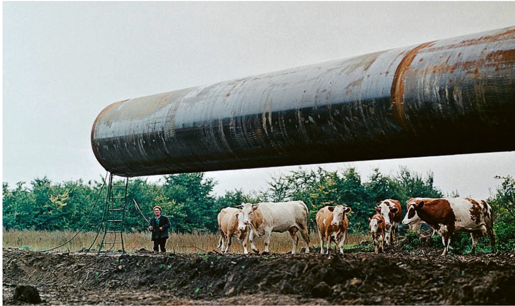
Erdgasrohr der Druschba-Trasse in der Ukraine
