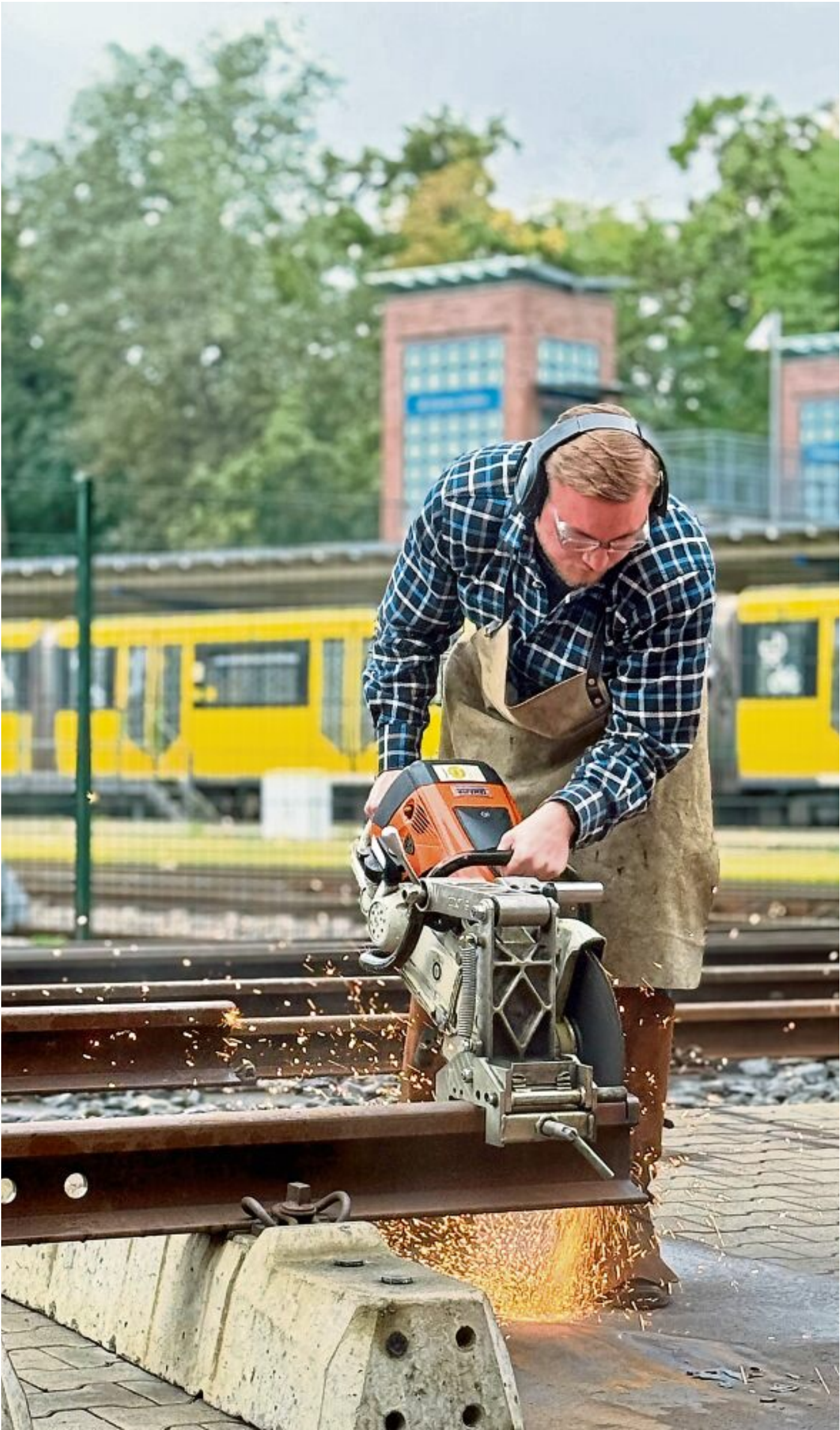
Gleisbauer müssen umfassendes Materialwissen haben und sicher im Umgang mit schwerem Gerät sein.
